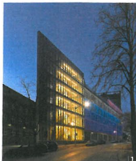
1 | Widok od południa na elewację wschodnią. Nocą iluminują ją LED-owe pasy o zmiennym kolorze i natężeniu światła. Według założeń projektu konkursowego jest to nawiązanie do osiągnięć pracowników naukowych UMCS, którzy w latach 70. XX w. jako pierwsi w Polsce zaprojektowali i skonstruowali światłowodów 2 | Nowy budynek instytutu wyznacza granicę między miastem a kampusem uniwersyteckim, na lewo od niego budynek Wydziału Matematyki, Fizyki i Informatyki
